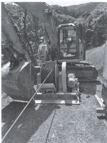
写真一 1 ウインチと0.45 m 3 油圧ショベル（重量物置換アンカー）
